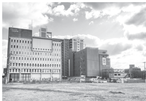
右側の新築中の建物に移転
